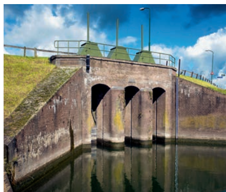
➔ Inundatiesluis in Wijk bij Duurstede.
