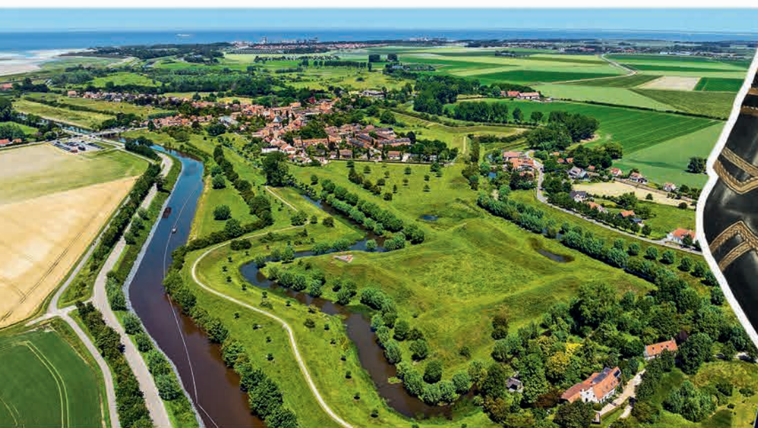
De oude vestingwallen van Retranchement zijn er nog vrijwel geheel aanwezig
