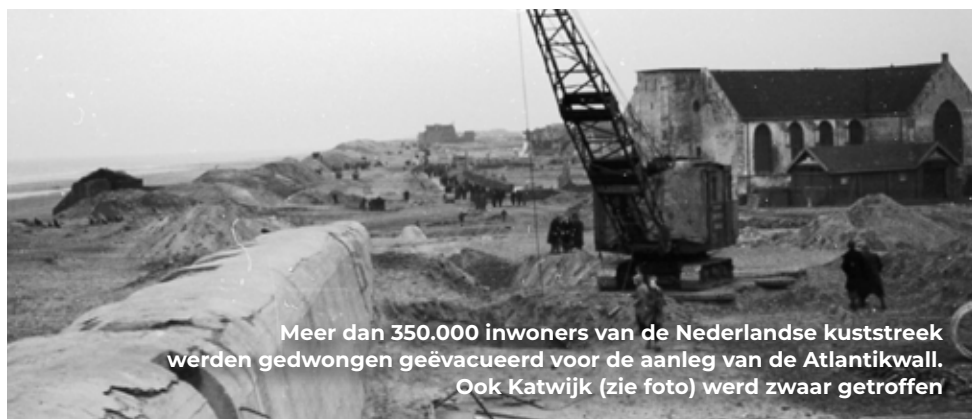
De aanleg van de Atlantikwall was een gigantische bouwooperatie waarvoor tienduizenden arbeiders nodig waren
